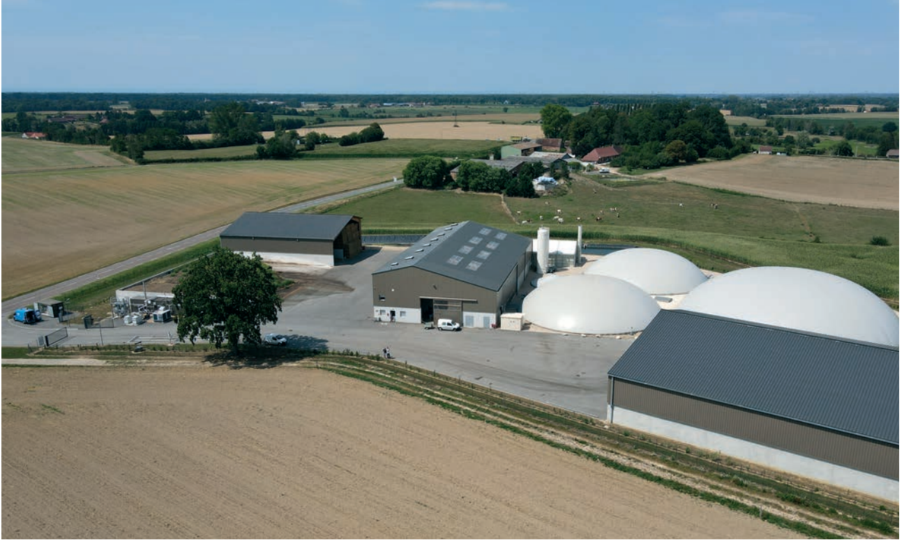
Biogasanlage mit Biomethanerzeugung
